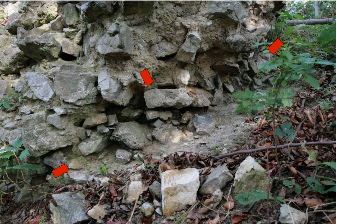
Abb.1.6 Die Unterminierung von Vorne.
