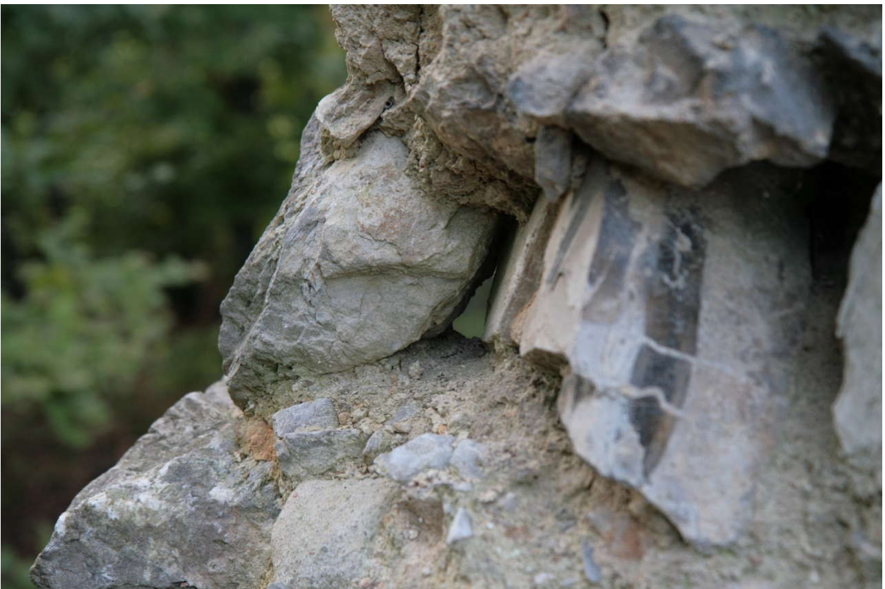
Abb.1.3 Das Regenwasser spült die Mauersteine frei.
