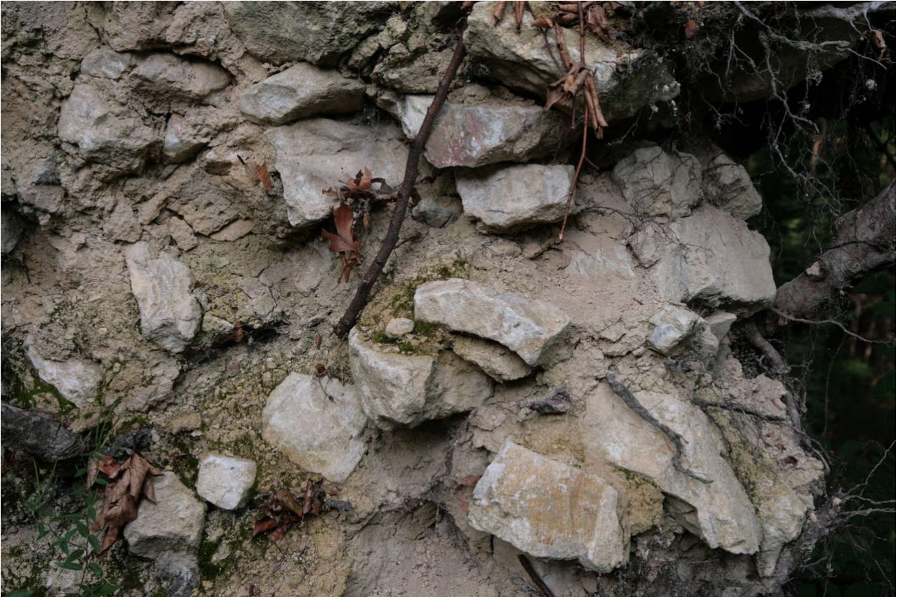
Abb.3.2 Nahaufnahme des Mauerwerks.
