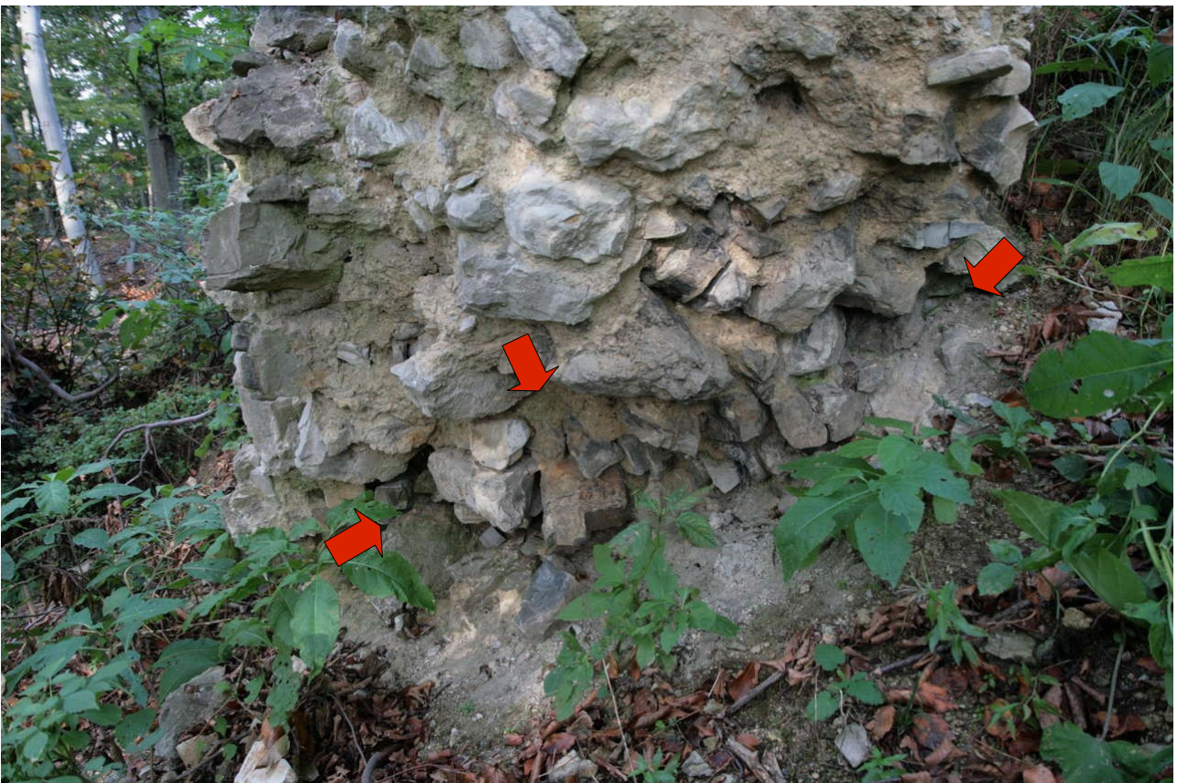
Abb.1.7 Die Unterminierung von der Seite.
