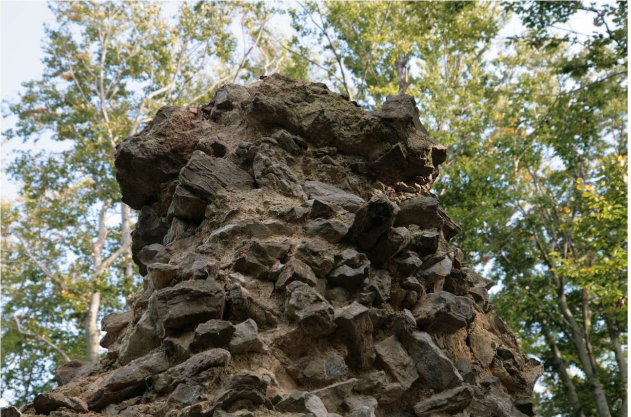
Abb.1.4 Außenseite des Turmsporns. Die kontinuierlich freigespülten Steine stürzen ringsum zu Boden.
