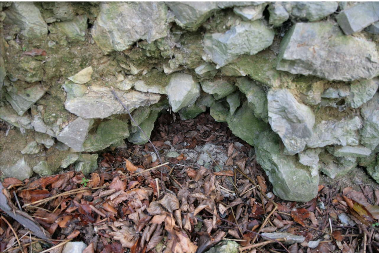
Abb.1.5 Am Fuße des Sporns klappt unter anderem ein Loch in der Mauer.
