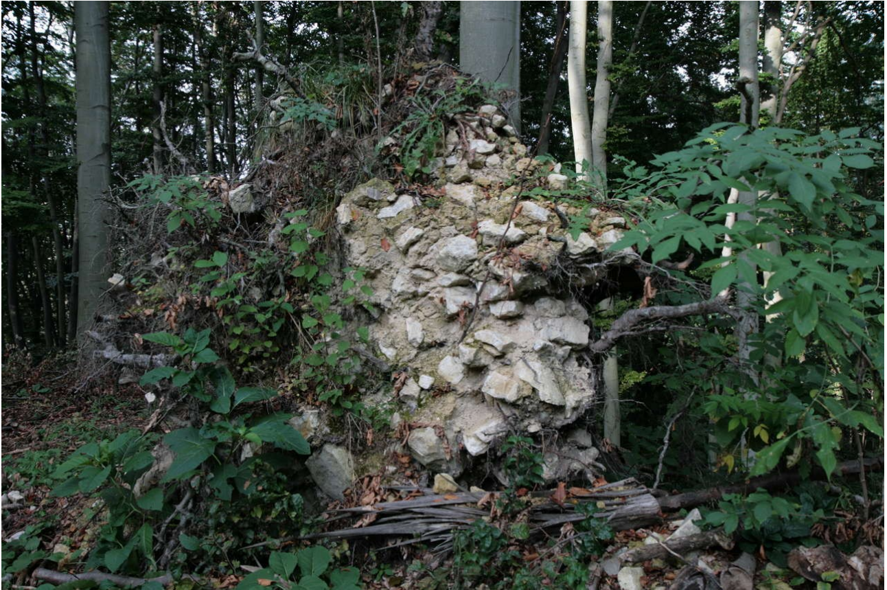
Abb.3.1 Das im Wurzelballen steckende massive Mauerwerk.
