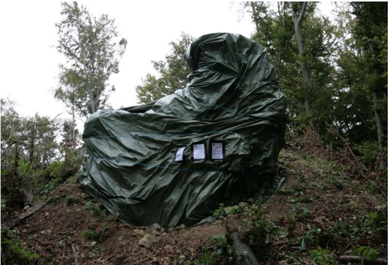
Abb.1.1 Der notdürftig vor Witterung geschützte, stark gefährdete Mauersporn.
