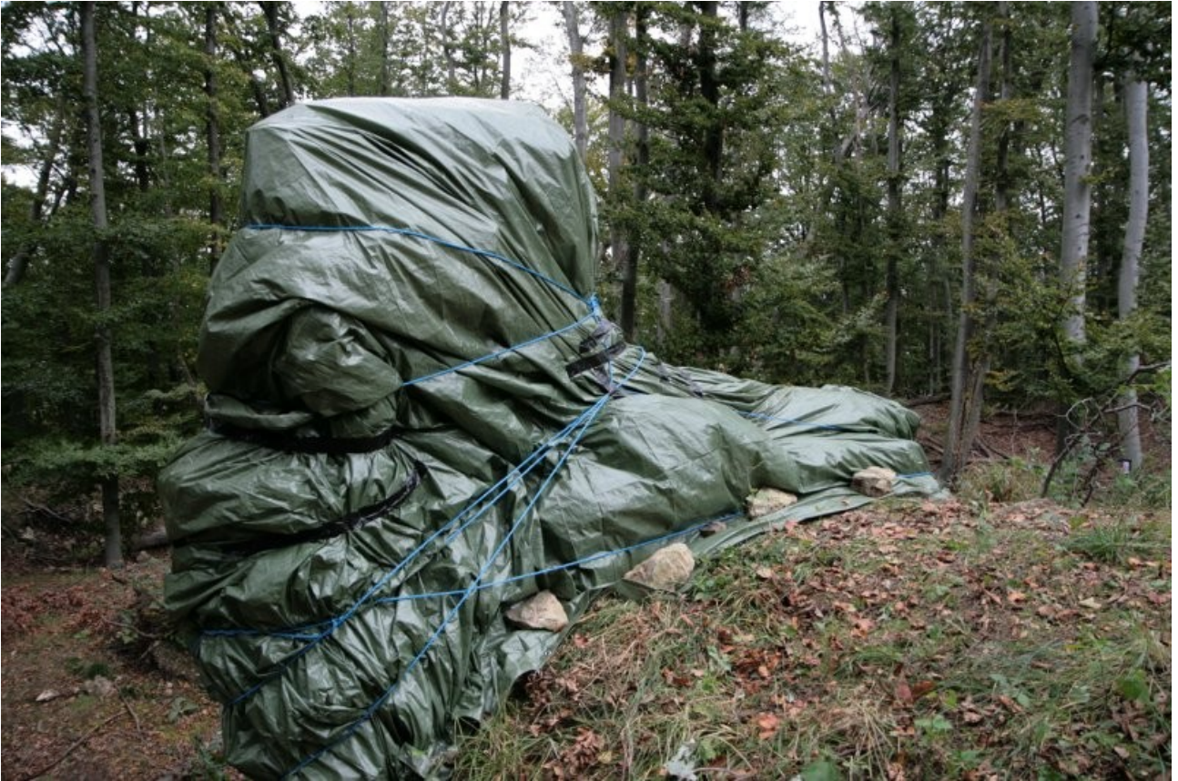
Abb.1.2 Die Turminnenseite, notdürftig vor weiterem Substanzverlust geschützt.
